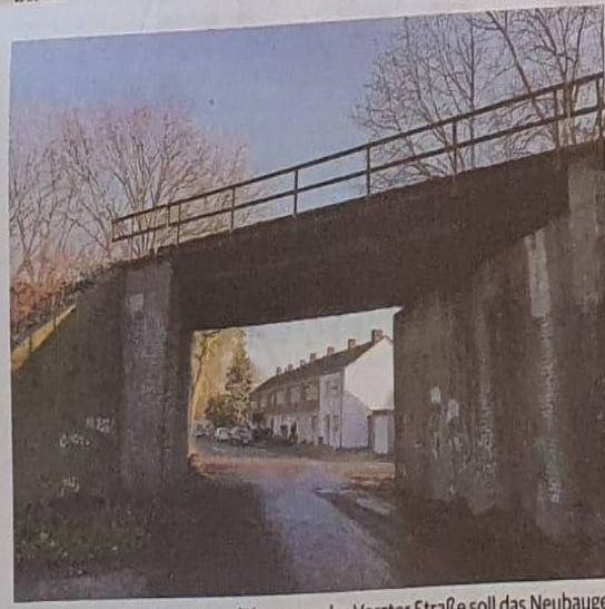
Durch diese stillgelegte Unterführung an der Vorster Straße soll das Neubaugebiet Tackheide erreichbar sein. Derzeit ist die Straße eine Sackgasse. ARCHIV: CPU
