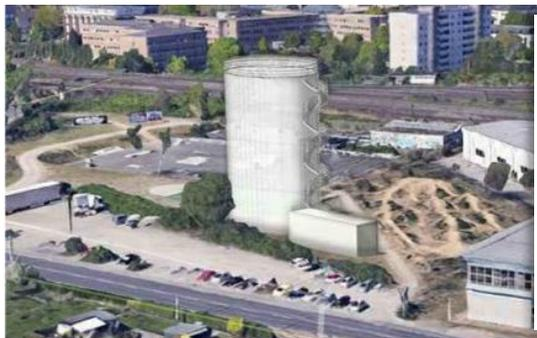
Bau eines **Wärmespeichers** zur Abdeckung von Volatilitäten und intelligente Steuerung von Wärmenetzen
